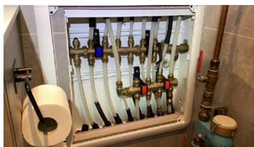
Fordelerskap på bad/vaskerom. Skruehull inne i skap bør tettes med egnet masse mtp vannsprut.
