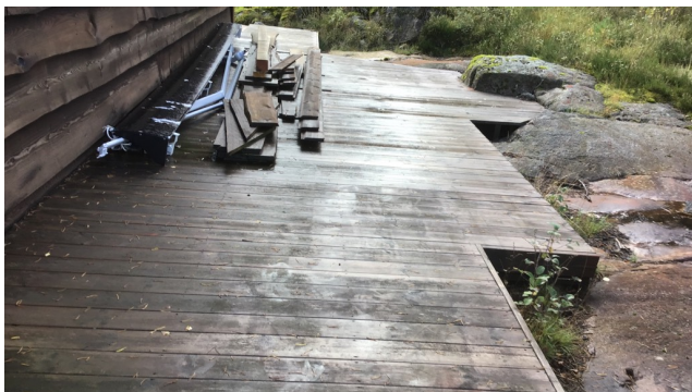
terasse ved bod
