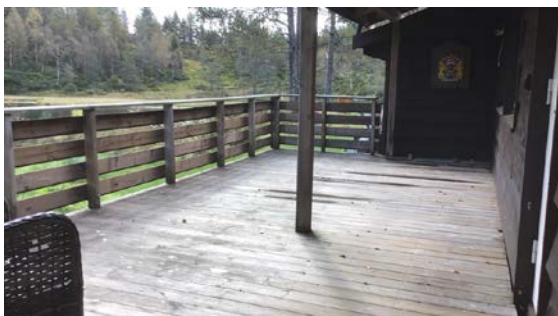
Terrasse ved inngang
