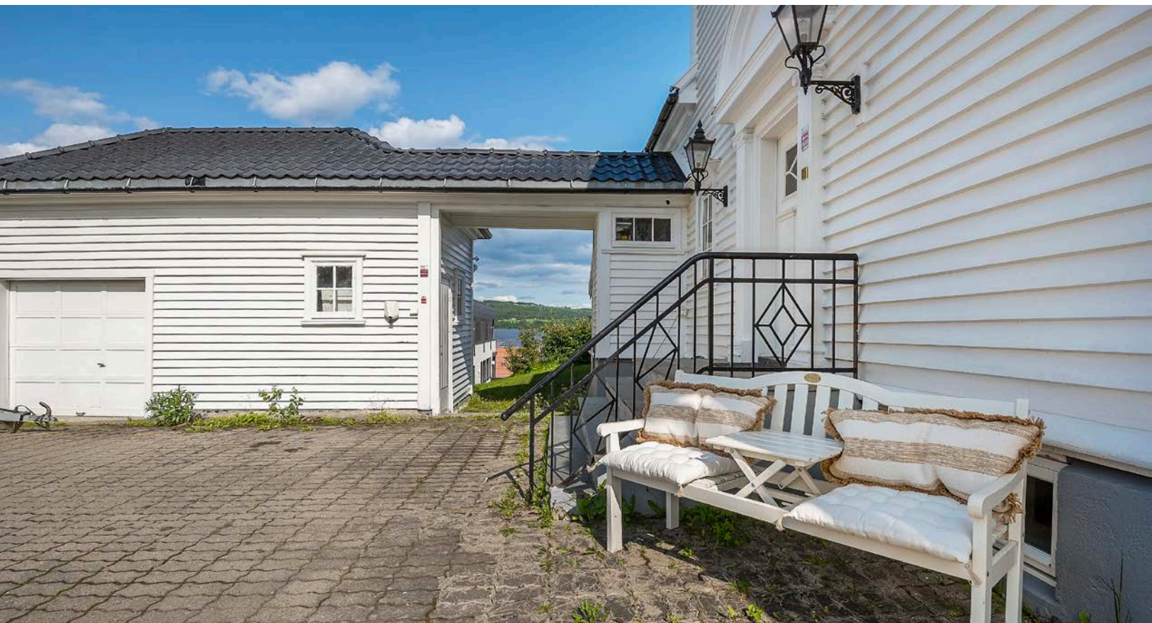
Belegningsstein foran inngangsparti og garasje.
