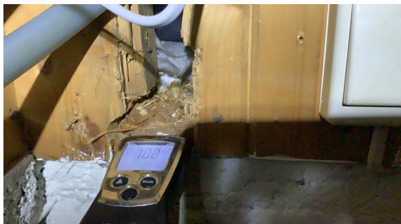
Fuktmåling, og det måles tørt.
