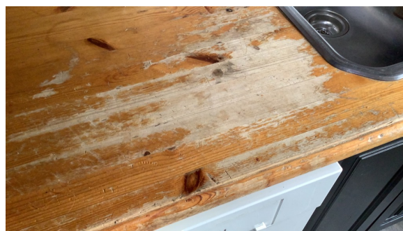
Slitasje i benkeplate.
