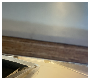
Bunnen av baderomsplater er ikke forseglet.
