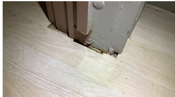
Eksempel på enkle avslutninger i gulv.
