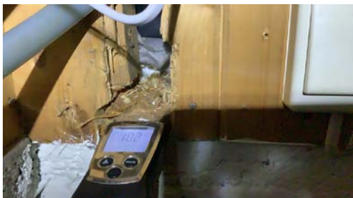
Fuktmåling, og det måles tørt.
