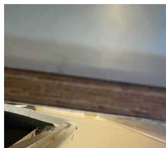
Bunnen av baderomsplater er ikke forseglet.
