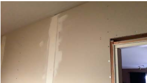
Soverom i tilbygg er ikke ferdigstilt.
