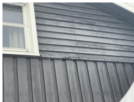
Kledning bærer stedvis preg av elde og slitasje.
