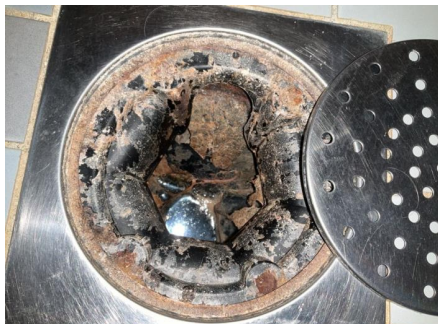
Ikke synlig membran i sluk.
