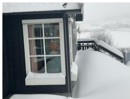
Taknedløp i kjelling. Det er ikke tilfredsstillende bortledning av vann fra taknedløp ved grunnmur.
