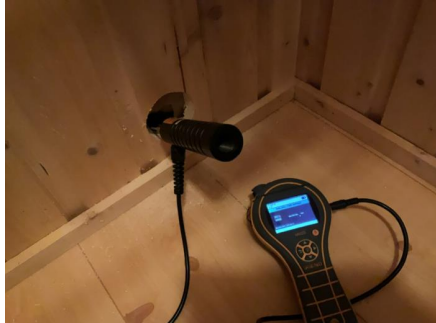
Ingen utslag ved fuktmåling i hulltaking i vegg mot dusjsone.
