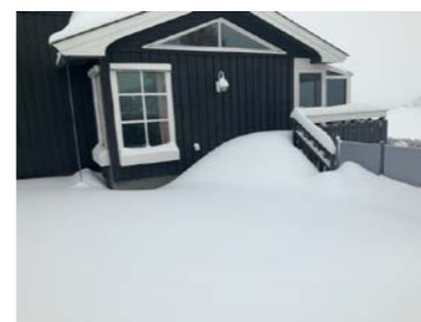
Balkonger/terrasse er snødekt og derfor ikke nærmere vurdert.
