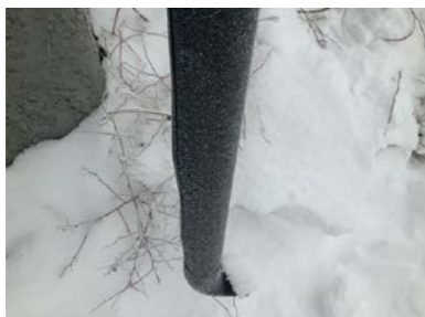
Frostsprengte takrennenedløp
