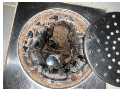
Ikke synlig membran i sluk.
