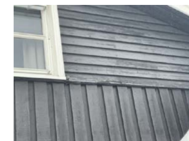
Endeved på utvendig kledning har enkelte steder ikke dryppkant, dette forkorter kledningens levetid. Kledning bærer stedvis preg av elde og slitasje.
