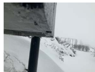
Endeved på utvendig kledning har enkelte steder ikke dryppkant, dette forkorter kledningens levetid. Kledning bærer stedvis preg av elde og slitasje.
