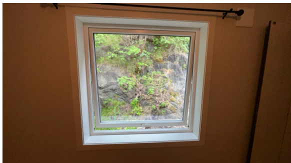
Eksempel på vindu i yttervegg.
