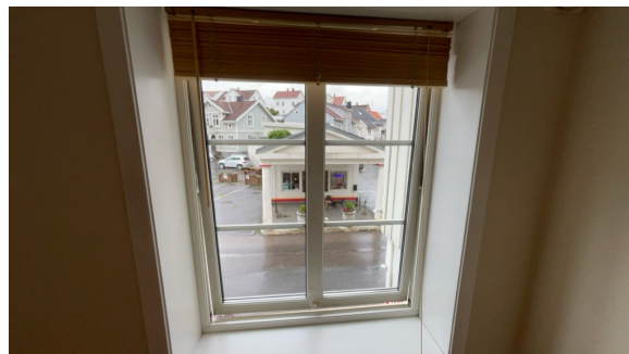
Eksempel på vindu i yttervegg.
