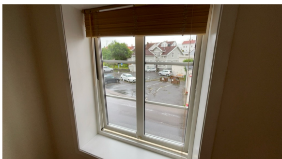
Eksempel på vindu i yttervegg.
