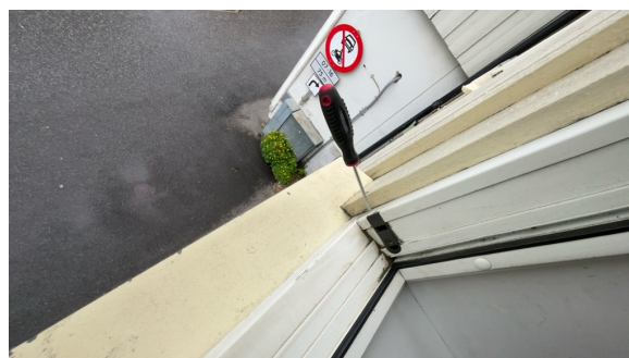
Stikkontroll på vinduer er utført.
