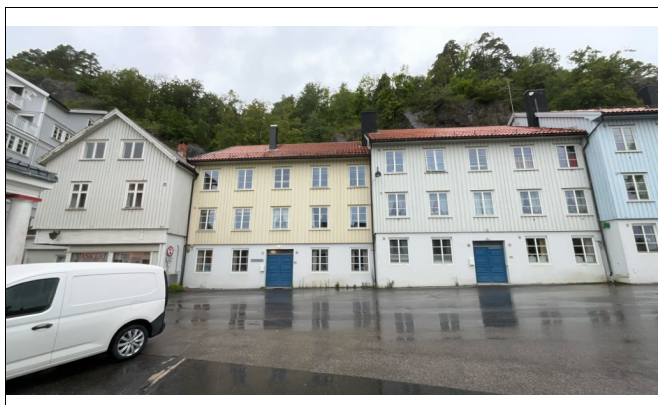
Bygget som leiligheten ligger i.
