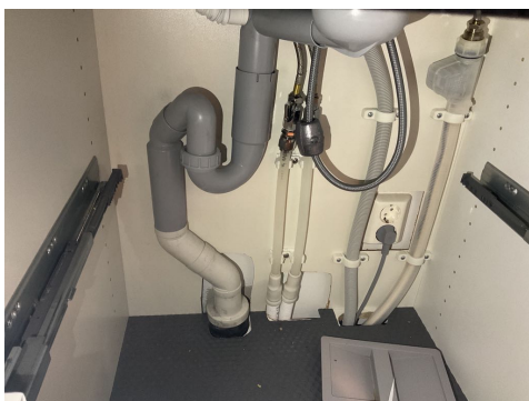
Synlige rør under kjøkkenbenken.
