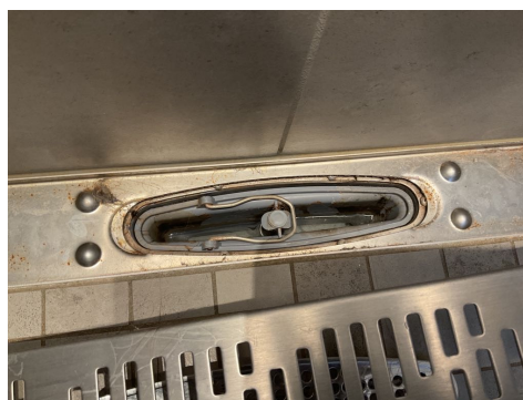
Slukrenne i dusjnisjen.
