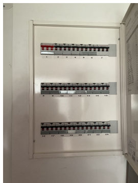
Sikringsskap med automatsikringer.
