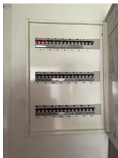
Sikringskap med automatsikringer.
