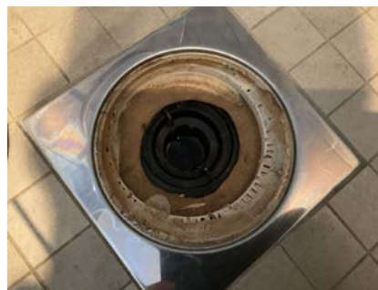
Plastsluk i gulv.
