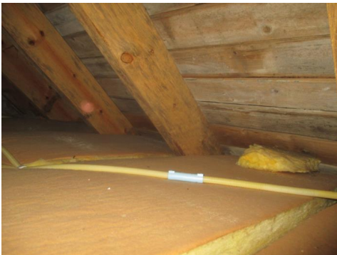
Skråtak er luftet innvendig.
