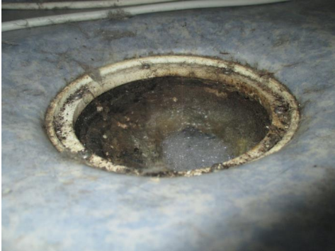
Sluk under innredning.
