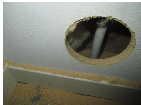
Hulltaking i fra skyvedørsgarderobe i gangen.
