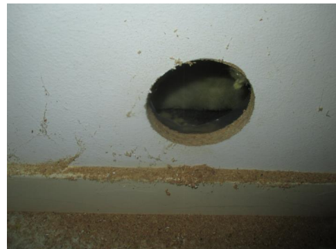
Hulltaking i utfored vegg på et lagerrom.
