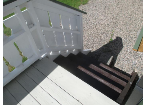
Trapp til terrasse.
