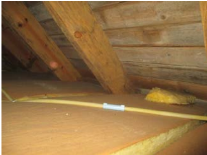
Skråtak er luftet innvendig.
