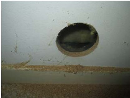
Hulltaking i utfored vegg på et lagerrom.
