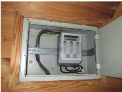
Hovedinntaket på loftstue.
