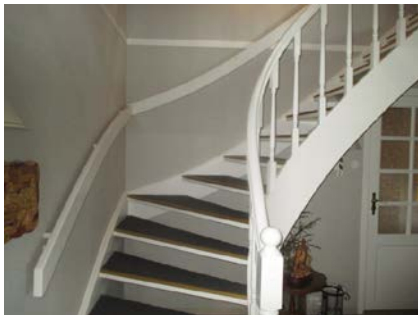
Trapp med åpne opptrinn til loftet.
