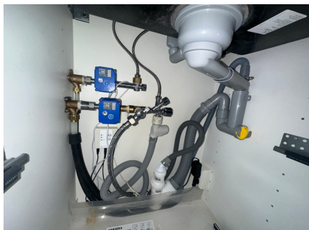
Rørapplegg i kjøkkenbenk med Waterguard
