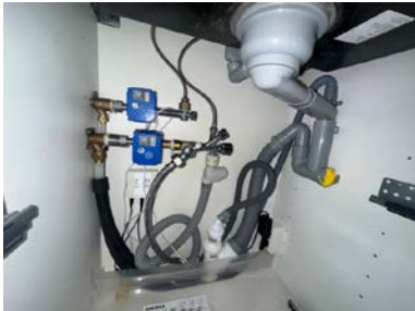
Røropplegg i kjøkkenbenk med Waterguard
