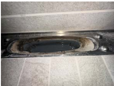
Slukrenne plassert i dusjnise
