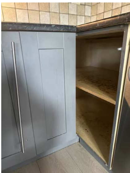
Håndtak er løst og front mangler.
