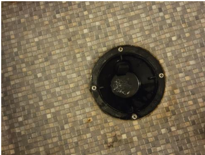
Membran, tettesjikt og overgang til sluk. - [Sluk]
