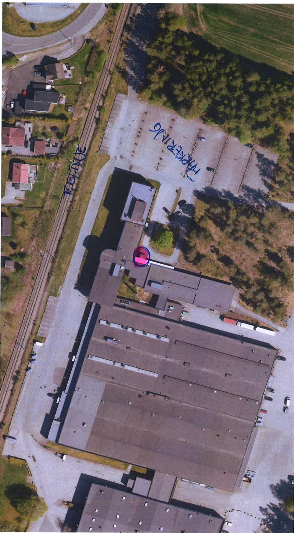
Østfold Næringspark, Vangsveien 10, Askim.
