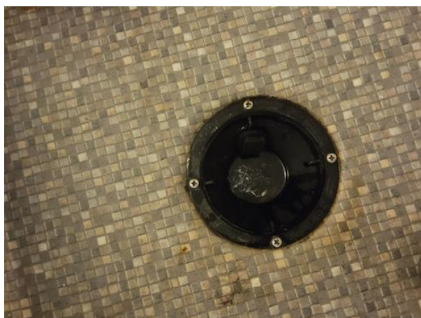
Membran, tettesjikt og overgang til sluk. - [Sluk]
