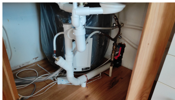
Kontroll etter lekkasjer.
