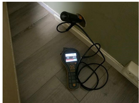
Utført hulltaking på rom under terreng.
