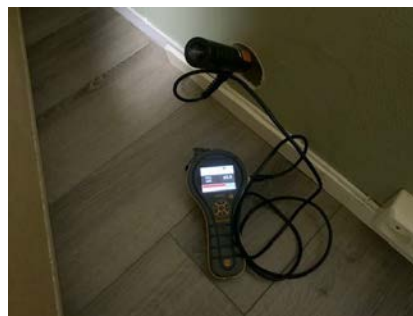
Utført hulltaking på rom under terreng.
