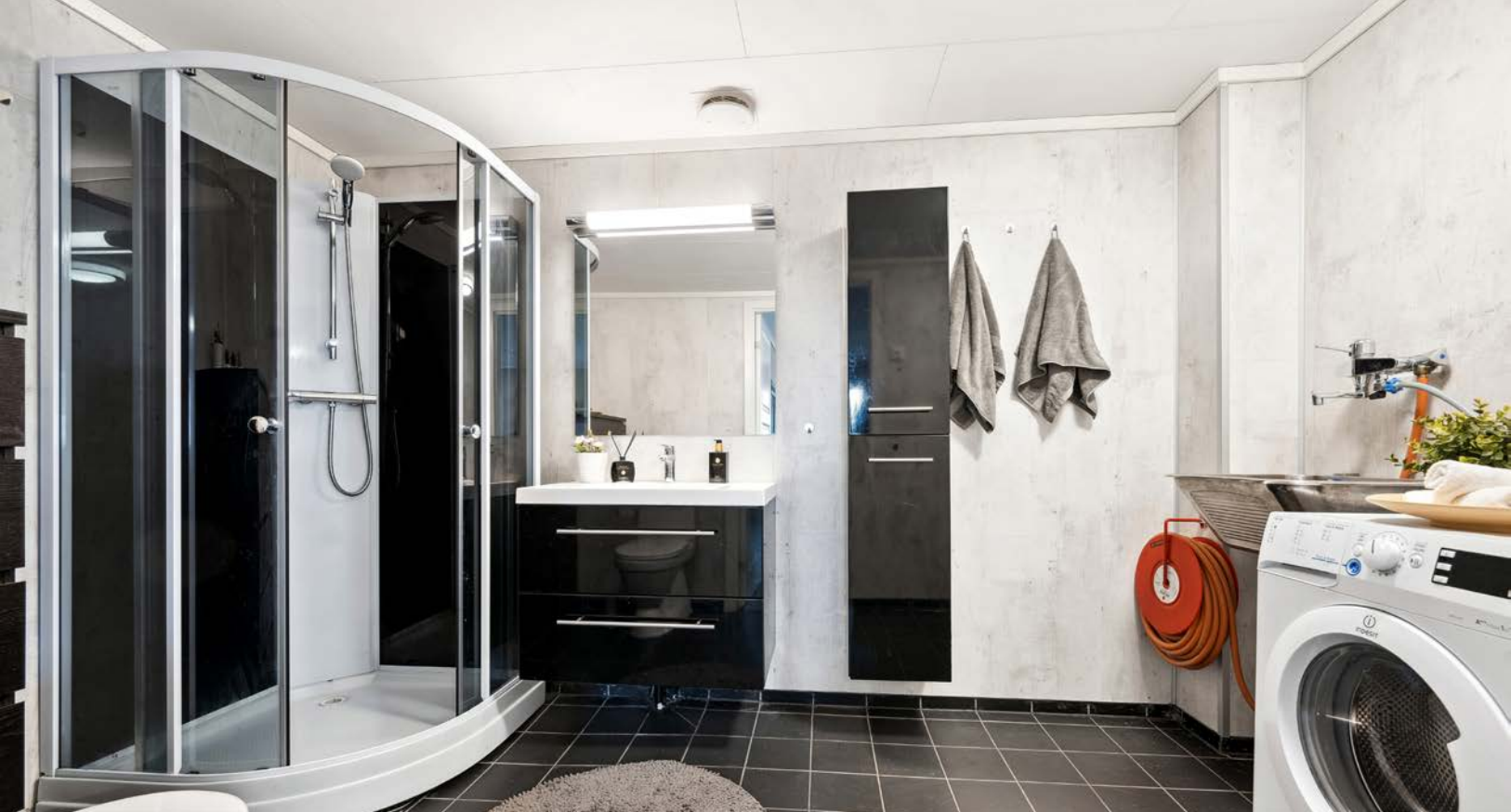
Badet har fliser på gulv og gulvvarme. På vegg er det montert våtromsplater.
