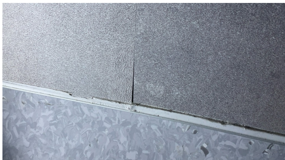
Svelling skjøt plate, venstre side vindu mot gulv før påføring av fugemasse.
