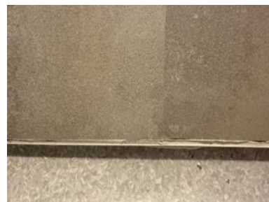
Plate etter at det er lagt på fugemasse i skjøt.
