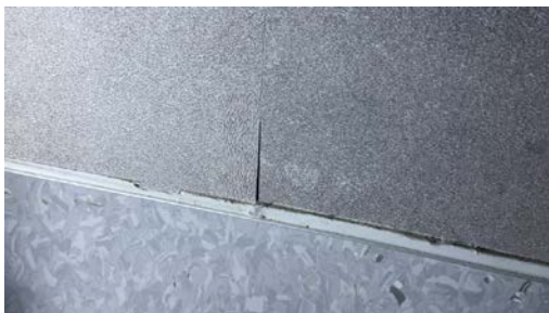
Svelling skjøt plate, venstre side vindu mot gulv før påføring av fugemasse.
