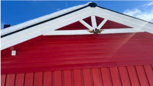
Råteskadet staffasje
