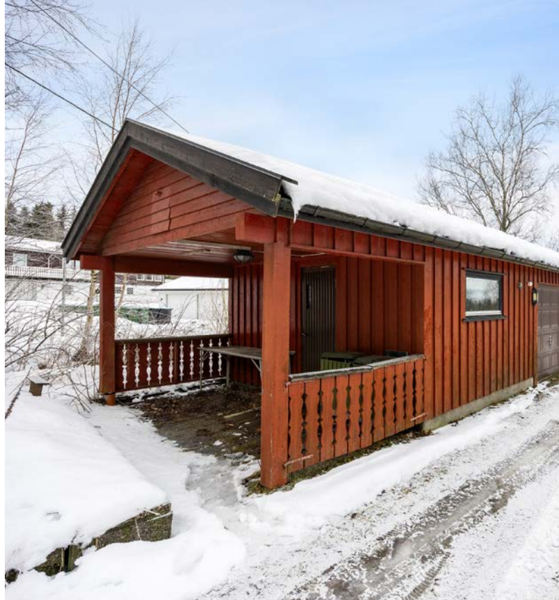
I tillegg er det overbygd uteplass i andre enden av garasjebygget.
