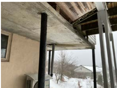
Eldre betongdekke henger løst.
