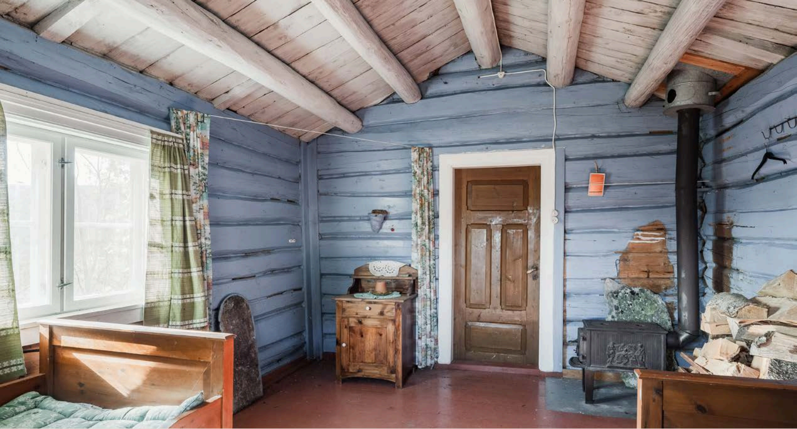
Gjestehytten har mønet himling med synlige rundstokker og en eldre vedovn i hjørnet av rommet.
