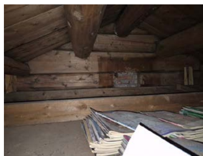
teglpipe plassert inntil laftevegg
