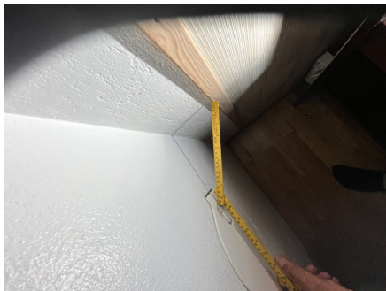
Avstand fra sotluke til brennbart
