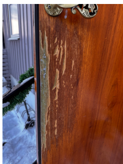
Manglende klaring mellom beslag og trekledning
