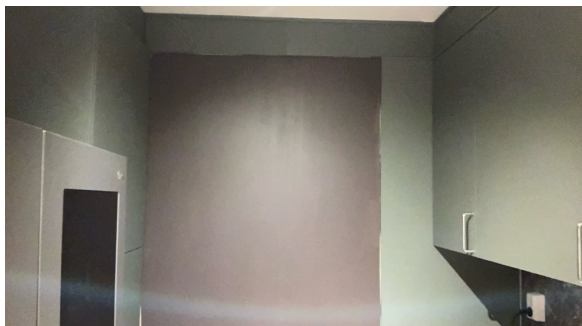
Dørhull som er tettet mot gang fra kjøkken
