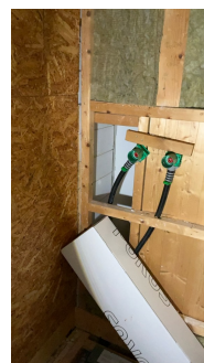
Pipen er innebygd med denne vegg på badet
