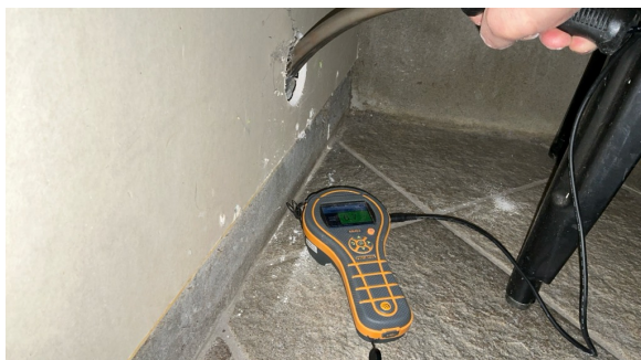
Ingen fuktutslag registrert ved fuktmåling i vegg
