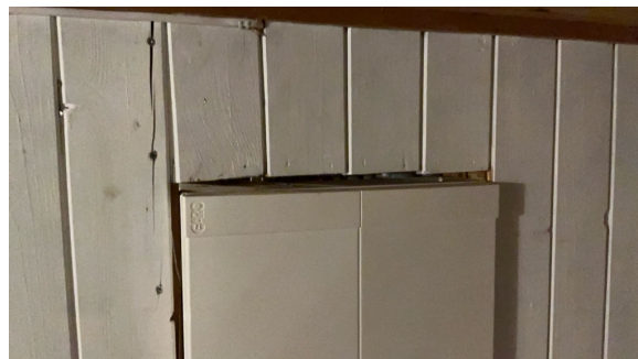
Vegg er ikke tett rundt sikringskap
