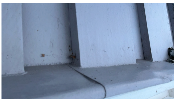
Manglende klaring mellom beslag og trekledning
