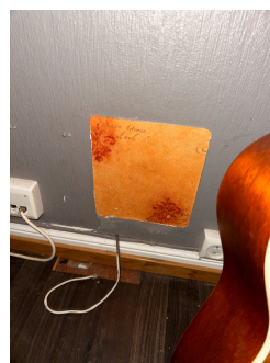
Vegg er ikke tett rundt sikringskap
