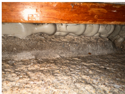
Bilde fra gangside, membran ikke synlig under terskel
