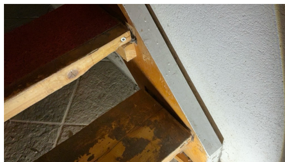
Nederste trinnene er utav sporene i vangen
