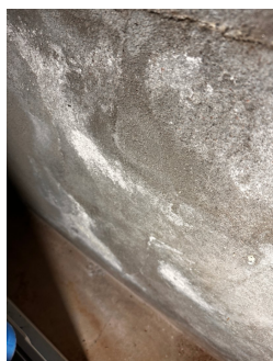
Fukt påvist ved fuktmåling i kjellerstuen
