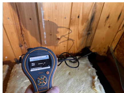
Ingen fuktutslag registret ved fuktmåling i i tak
