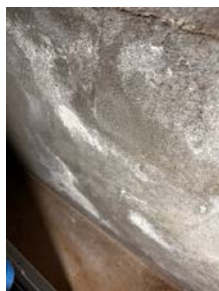
Fukt påvist ved fuktmåling i kjellerstuen
