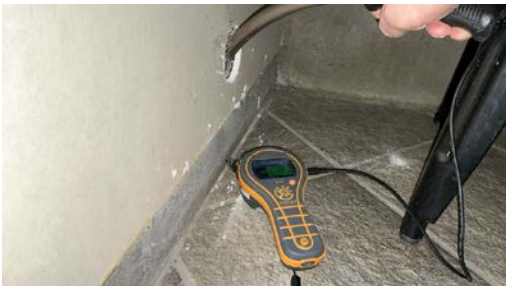
Ingen fuktutslag registret ved fuktmåling i vegg
