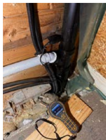
Ingen fuktutslag registrert ved fuktmåling i vegg
