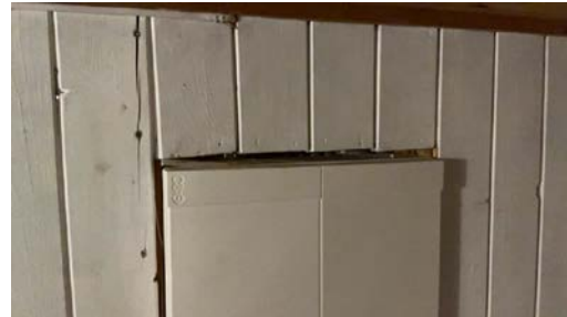
Vegg er ikke tett rundt sikringskap
