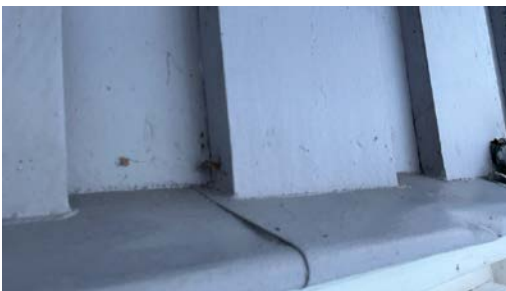
Manglende klaring mellom beslag og trekledning
