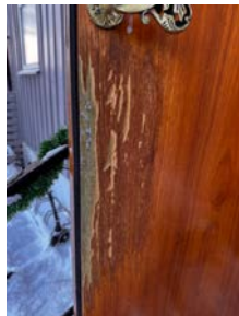
Manglende klaring mellom beslag og trekledning
