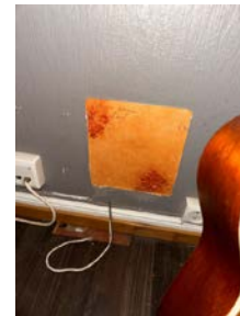
Vegg er ikke tett rundt sikringskap
