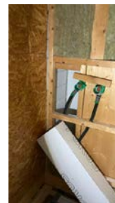
Pipen er innebygd med denne vegg på badet
