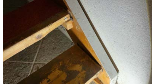
Nederste trinnene er utav sporene i vangen
