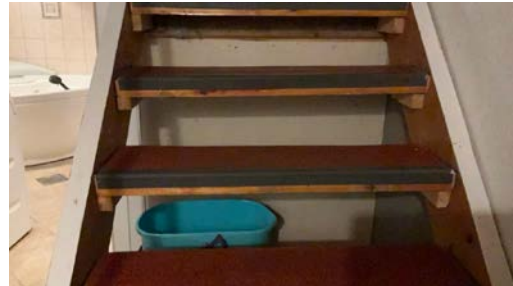
For stor åpning mellom trinn i kjellertrapp
