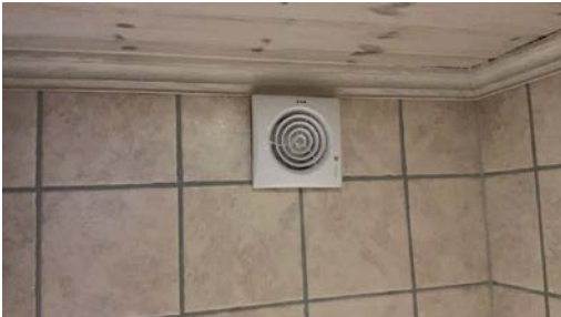
Vifte i vegg
