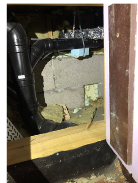
Bilde av rom med avløpsrør under hytten
