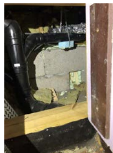
Bilde av rom med avløpsrør under hytten
