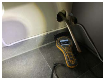
Hulltaking i vaskeromsvegg.
