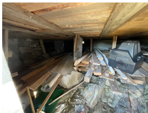
Krypkjeller sett fra luke i grunnmur
