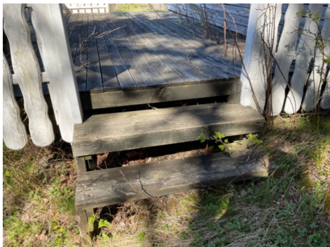
Trapp fra treterrasse
