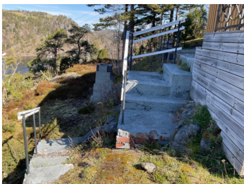
Murt trapp til terrasse
