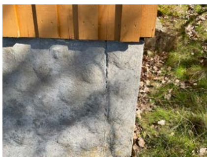
Vertikal sprekk
