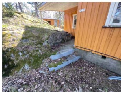
Betongtrapp til inngangsparti
