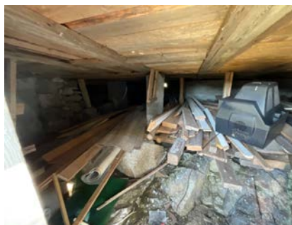
Krypkjeller sett fra luke i grunnmur
