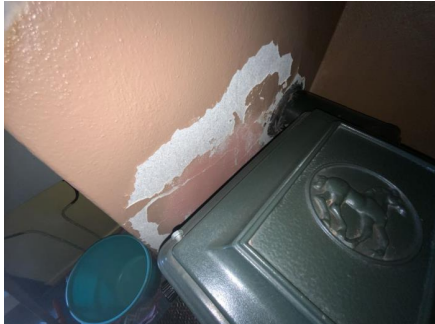
Noe synlig sorekk i puss på pipe ved vedovn på vaskerom.
