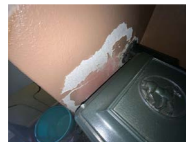
Noe synlig sorekk i puss på pipe ved vedovn på vaskerom.
