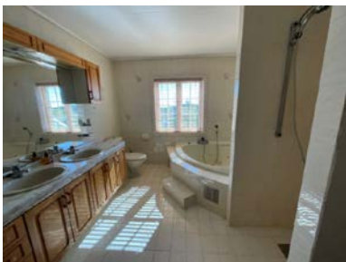
Sprekk i fliser i våtsoner.
