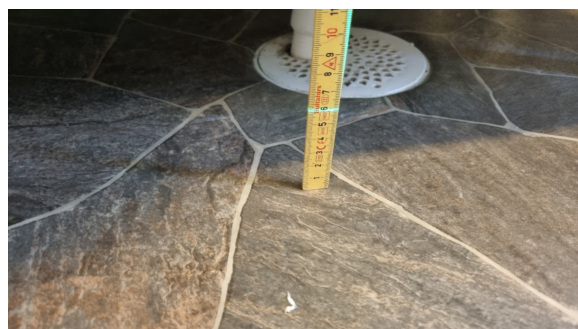
Kontroll av fall/høydeforskjell.
