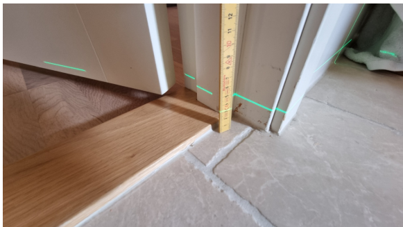
Kontroll av fall/høydeforskjell.
