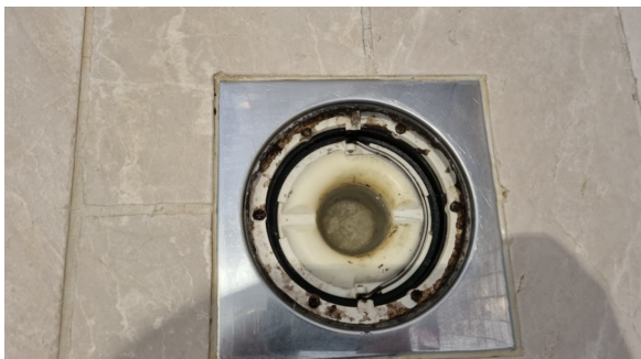
Kontroll av sluk.
