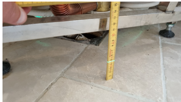
Kontroll av fall/høydeforskjell.
