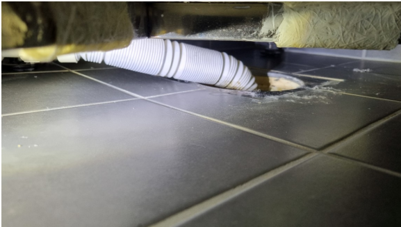
Kontroll av sluk.
