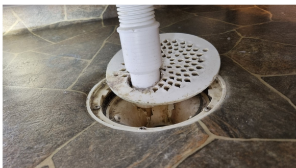
Kontroll av sluk.
