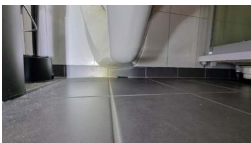
Drensåpning for synliggjøring av eventuelt lekkasjevann fra systerne.
