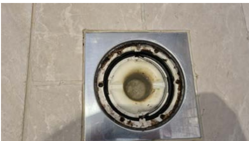
Kontroll av sluk.
