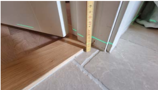
Kontroll av fall/høydeforskjell.
