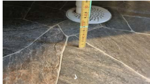
Kontroll av fall/høydeforskjell.
