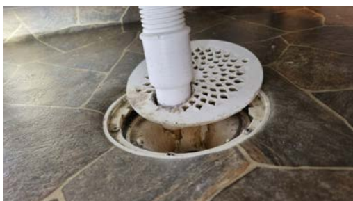
Kontroll av sluk.
