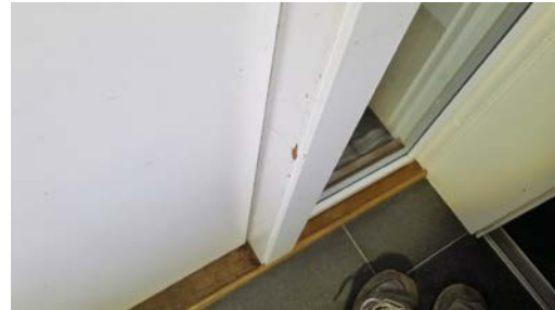
Overflateslitasje.
