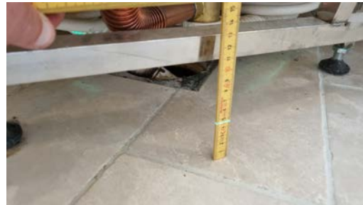
Kontroll av fall/høydeforskjell.
