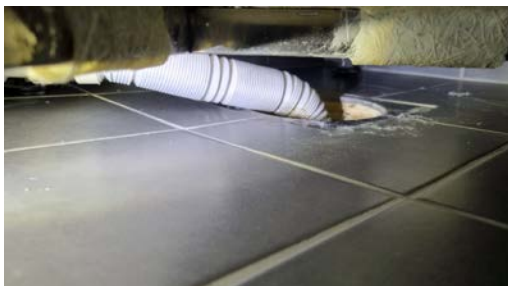
Kontroll av sluk.
