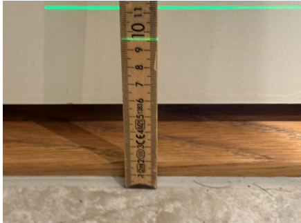
Fallforhold ca. 96 mm overkant gulv ved terskel
