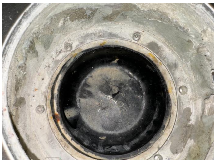
Plastsluk med klemring og synlig membran/mansjett
