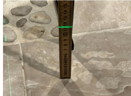
Fallforhold ca. 115 mm overkant gulv ved dusjsone
