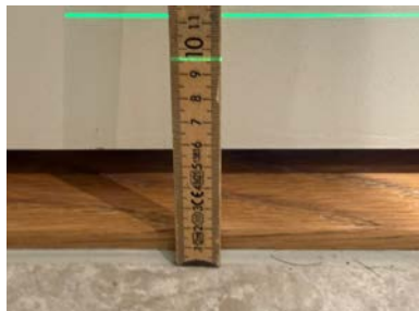
Fallforhold ca. 96 mm overkant gulv ved terskel
