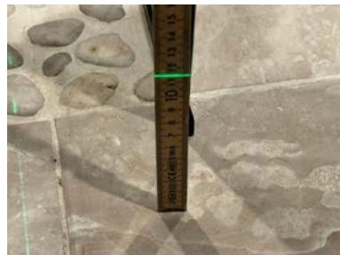
Fallforhold ca. 115 mm overkant gulv ved dusjsone
