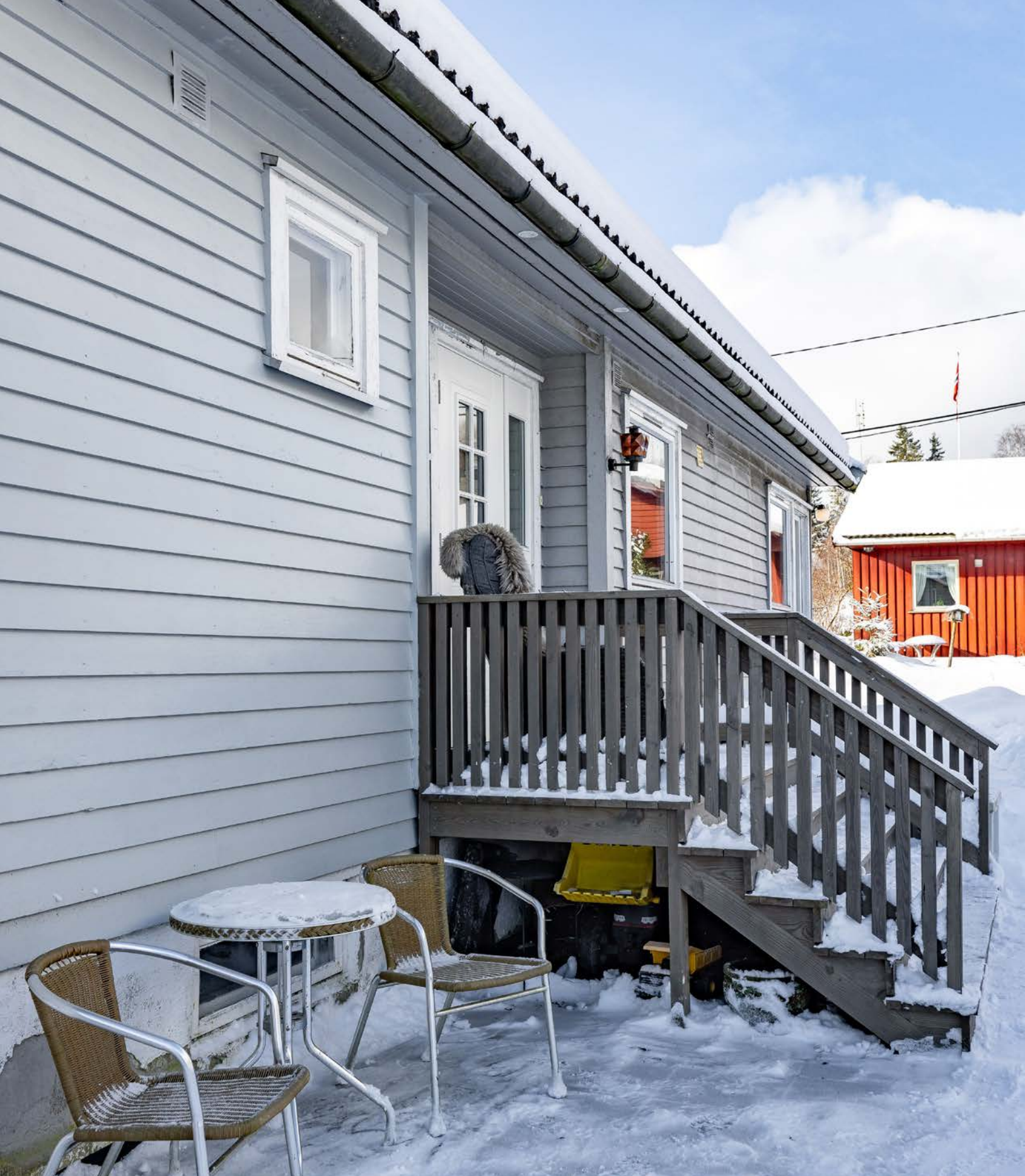
Utført delvis dreneringsarbeid ved inngangsparti i 2018 (gravd opp og lagt dreneringsslange, lagt betongfliser).
