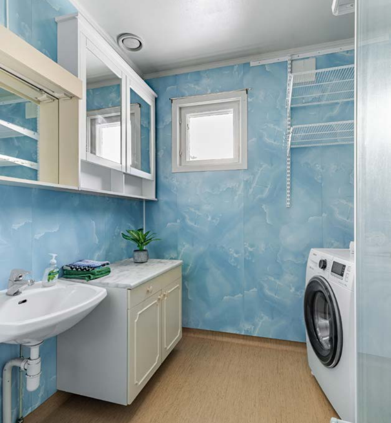
Boligen har et originalt baderom med vinylbelegg på gulv og våtromsplater på veggene.
