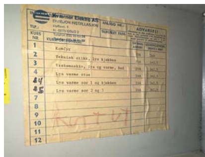
Kurversikt i sikringsskap
