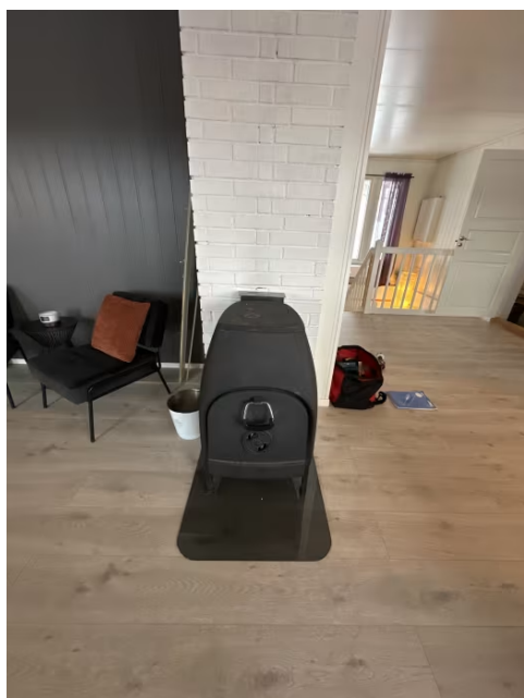
Viser ildsted i stue 1.etasje.
