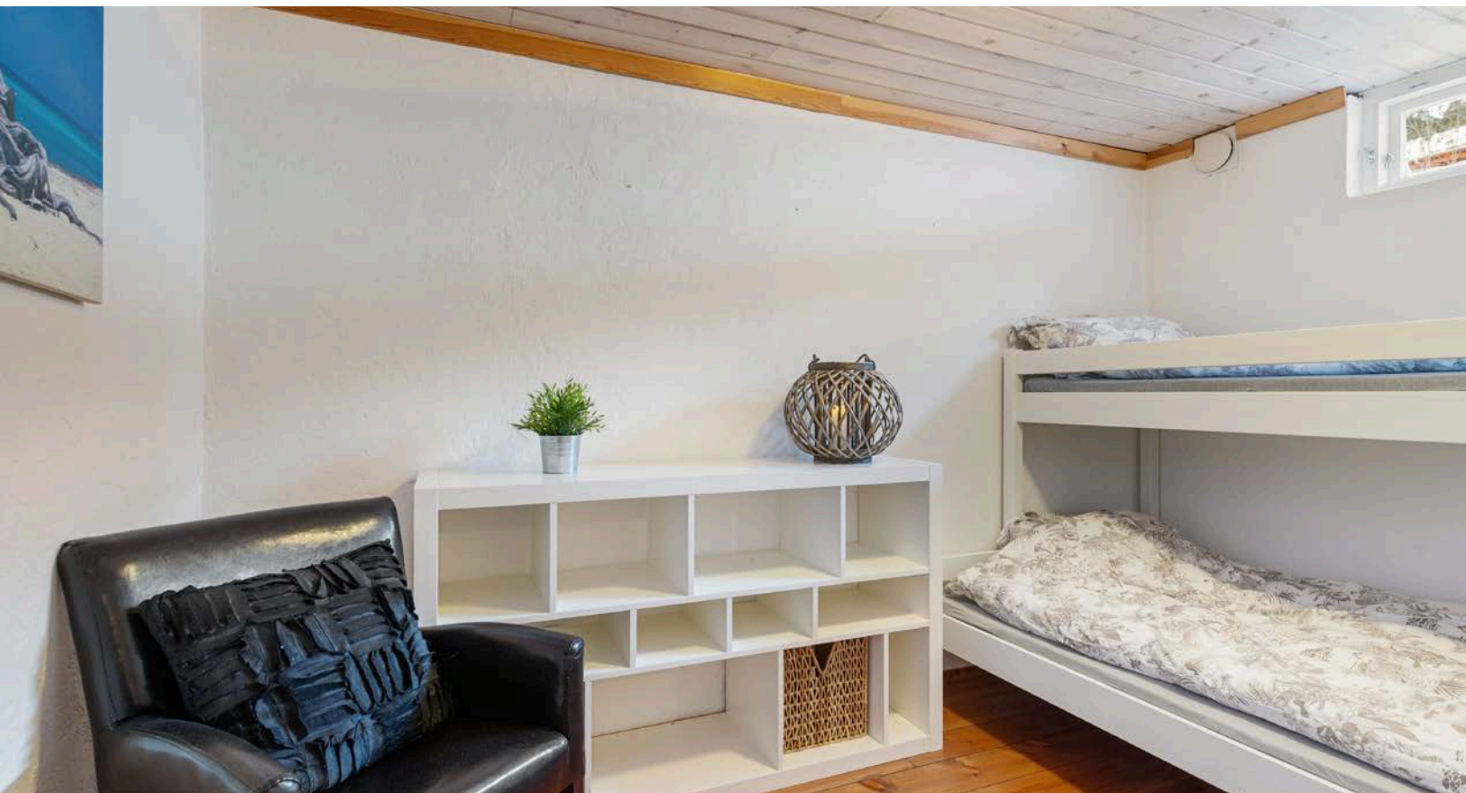
Rom i sokkeletasje, innredet som soverom. Her er det parkettgulv og malte murvegger. Rommet er ikke godkjent for varig opphold.
