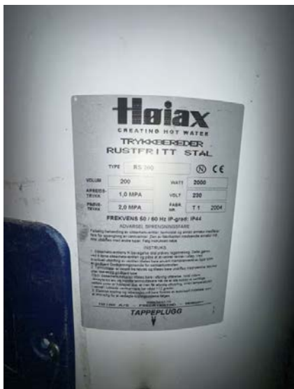
Viser teknisk data på bereder.
