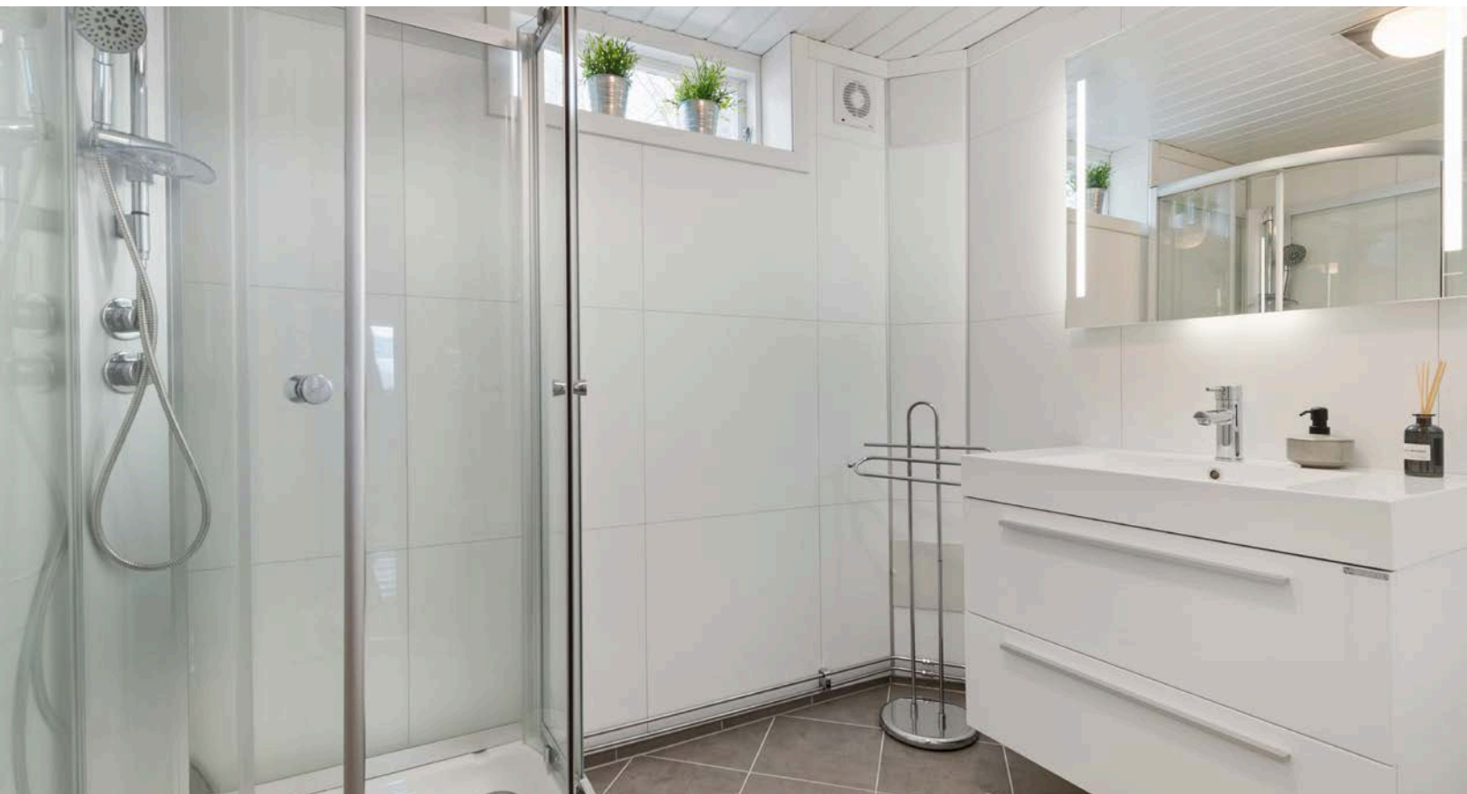
Bad i sokkel fra 2016 med flislagt gulv og våtromsplater på vegger. Baderomsinnredning med servant på underskap og speil med belysning over. Ellers er det installasjoner med dusjkabinett og kverntoilett. Varmekabler i gulvet.
