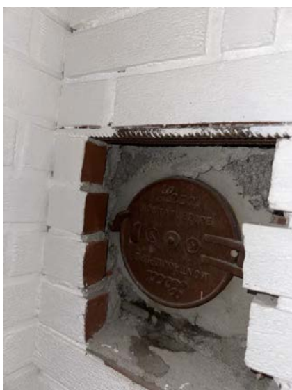
Sotluke plassert i kjeller på soverommet.
