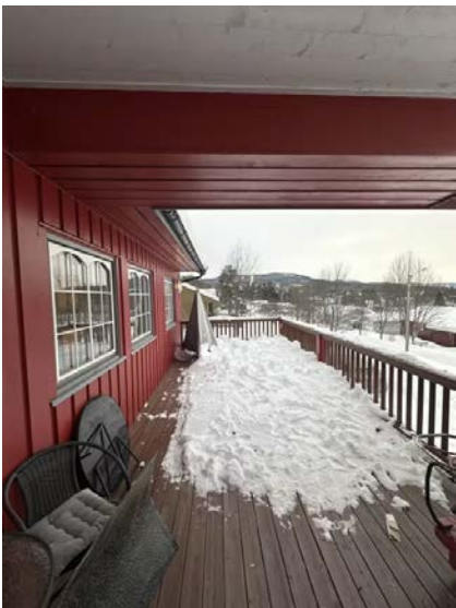
Viser veranda med adkomst fra stue og terreng.
