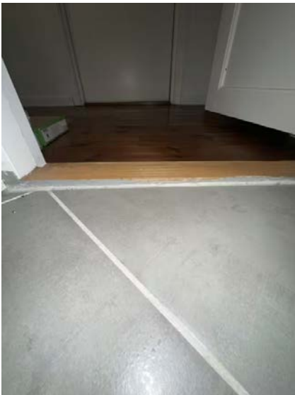
Synlig oppbrett av membran ved døråpning. Anbefales klemt med list.
