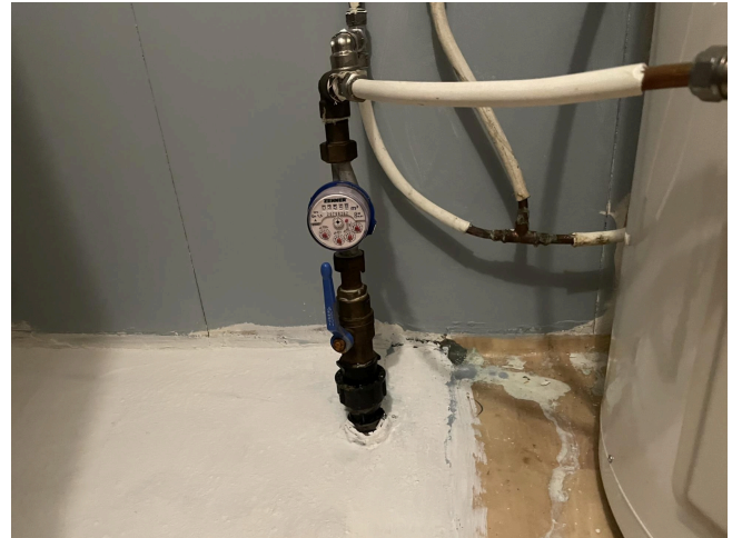
Stoppekrav funksjonstestet.
