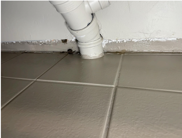
Gjennomføring våtsone gulv
