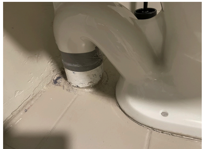
Gjennomføring våtsone gulv.
