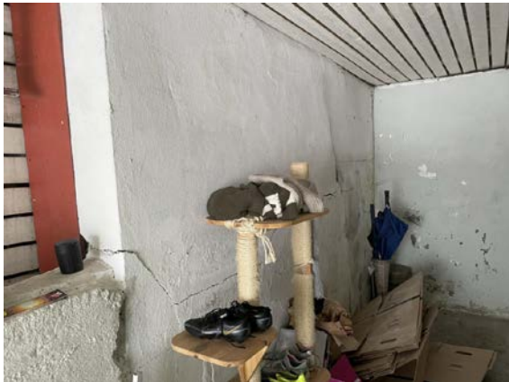
Støttemur ved atkomst til kjellerleilighet.
