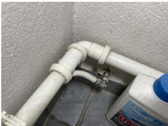
Synlige vann og avløpsrør.
