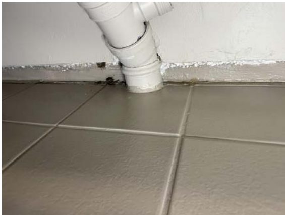
Gjennomføring våtsone gulv
