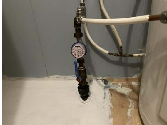
Stoppekran funksjonstestet.
