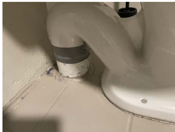
Gjennomføring våtsone gulv.
