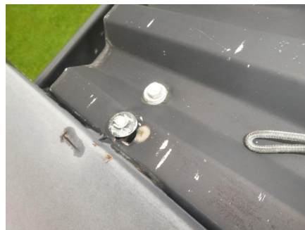
Utettheter rundt innfesting i taktekingen.
