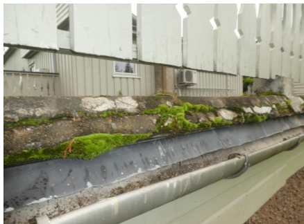
Mose på terrasse/tak over del med basseng
